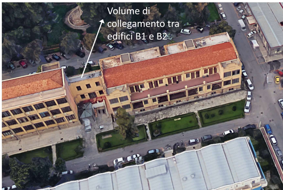
Fig.20. Vista dell'edificio B1 con particolare del volume di collegamento all'edificio B2.
